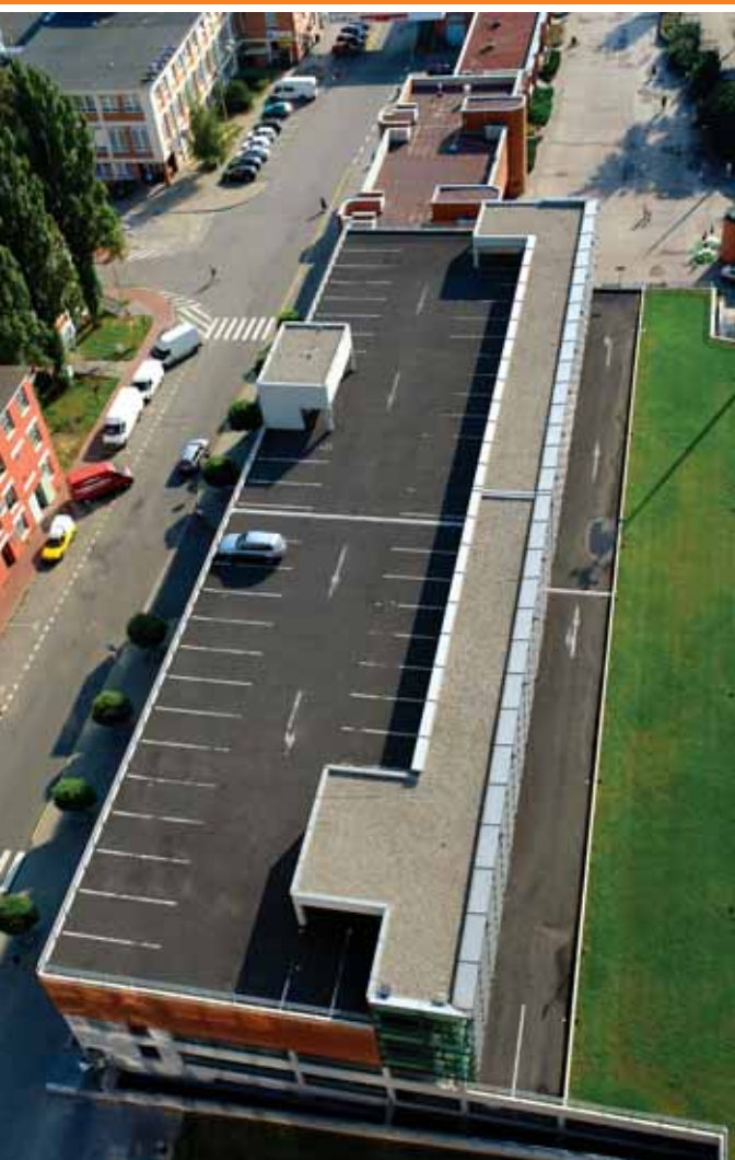
Střešní parkoviště Zlín, plocha: 2.000 m 2 , realizováno v roce 2004
