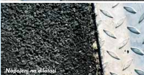
Detail lepení modifikovaného pásu
