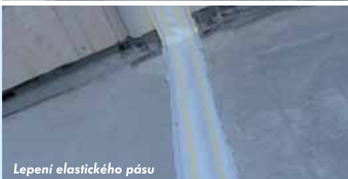
Detail utěsnění kolem vpusti
